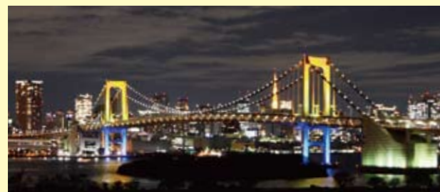
レインボーブリッジ (平成5年8月26日開通) The Rainbow Bridge (Open August 26, 1993)
