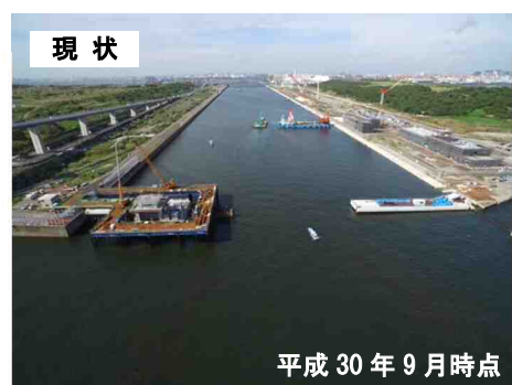
東側水門及び締切堤現場写真
