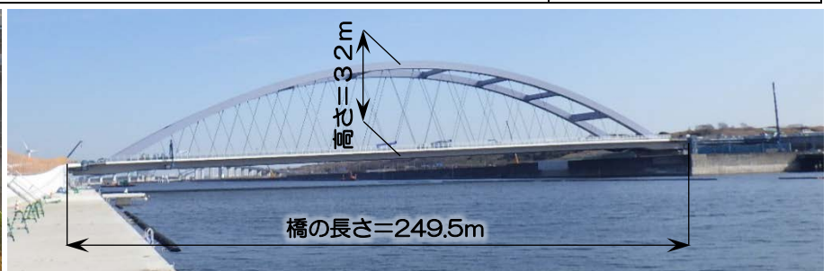
橋りょう区間 施工状況写真 (平成31年1月撮影)
